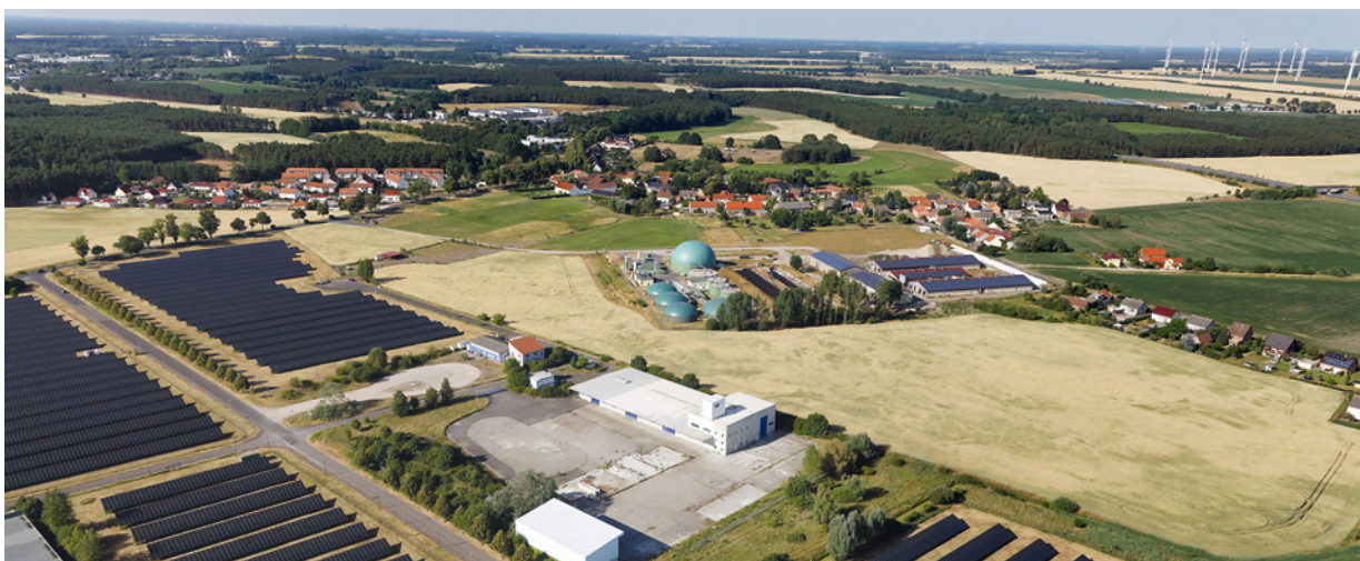
Energiewende mitgestalten © Jürgen Hohmuth im Auftrag des BBSR
