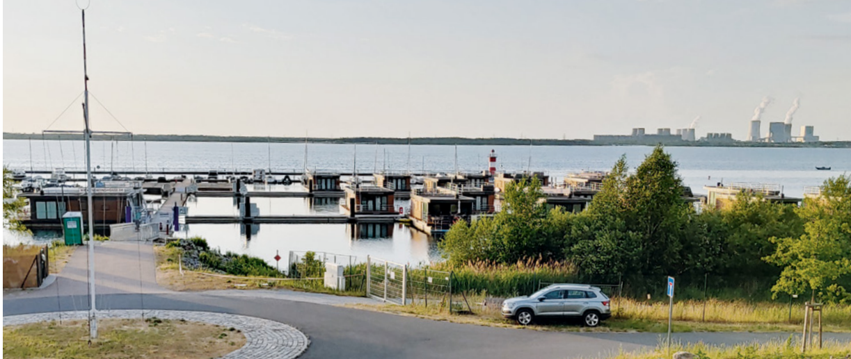
Sinnbild des Strukturwandels in der Region: Marina mit Floating Houses und Braunkohlekraftwerk Boxberg/OL am Bärwalder See © ZV LSS/Jochen Rausch (Modellvorhaben Strategisches Entwicklungs- und Handlungskonzept für das länderübergreifende Lausitzer Seenland)
