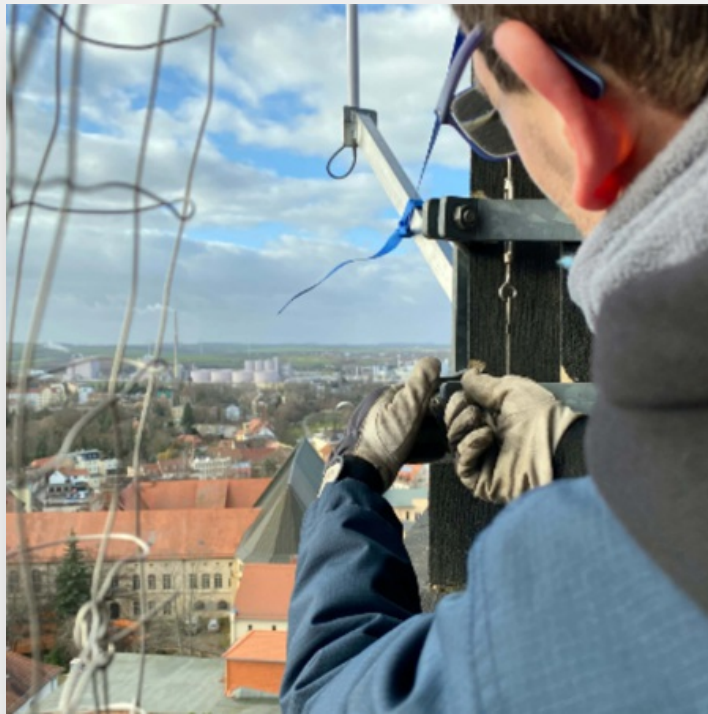
Installation der Antenne des LoRaWAN Gateways auf dem Rathausturm. © Jenny Gräfe/DZZ
